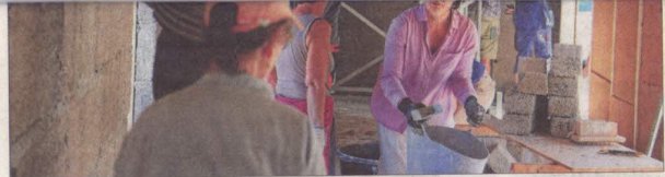
På de ti dags workshop, har en række frivillige betalt sig til at bygge på fælleshuset, og samtidigt få en masse nyttig viden om det at bygge klimavenligt og bæredygtigt.
